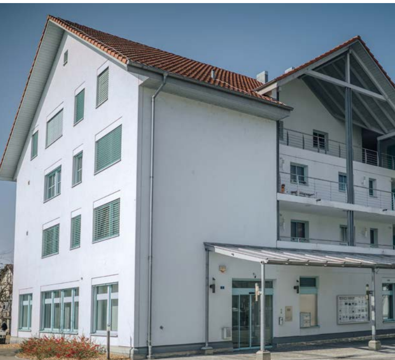
In diesem Gebäude befindet sich die Rechenzentrale von Sileo, in den Räumen einer ehemaligen Bankfiliale.
